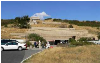
丘を掘って建設した案内センター
